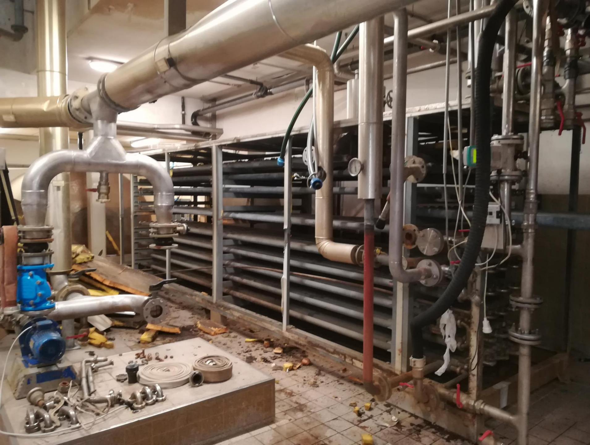
Abbruch des alten Wärmetauschers zur Beheizung des Faulturmes...
