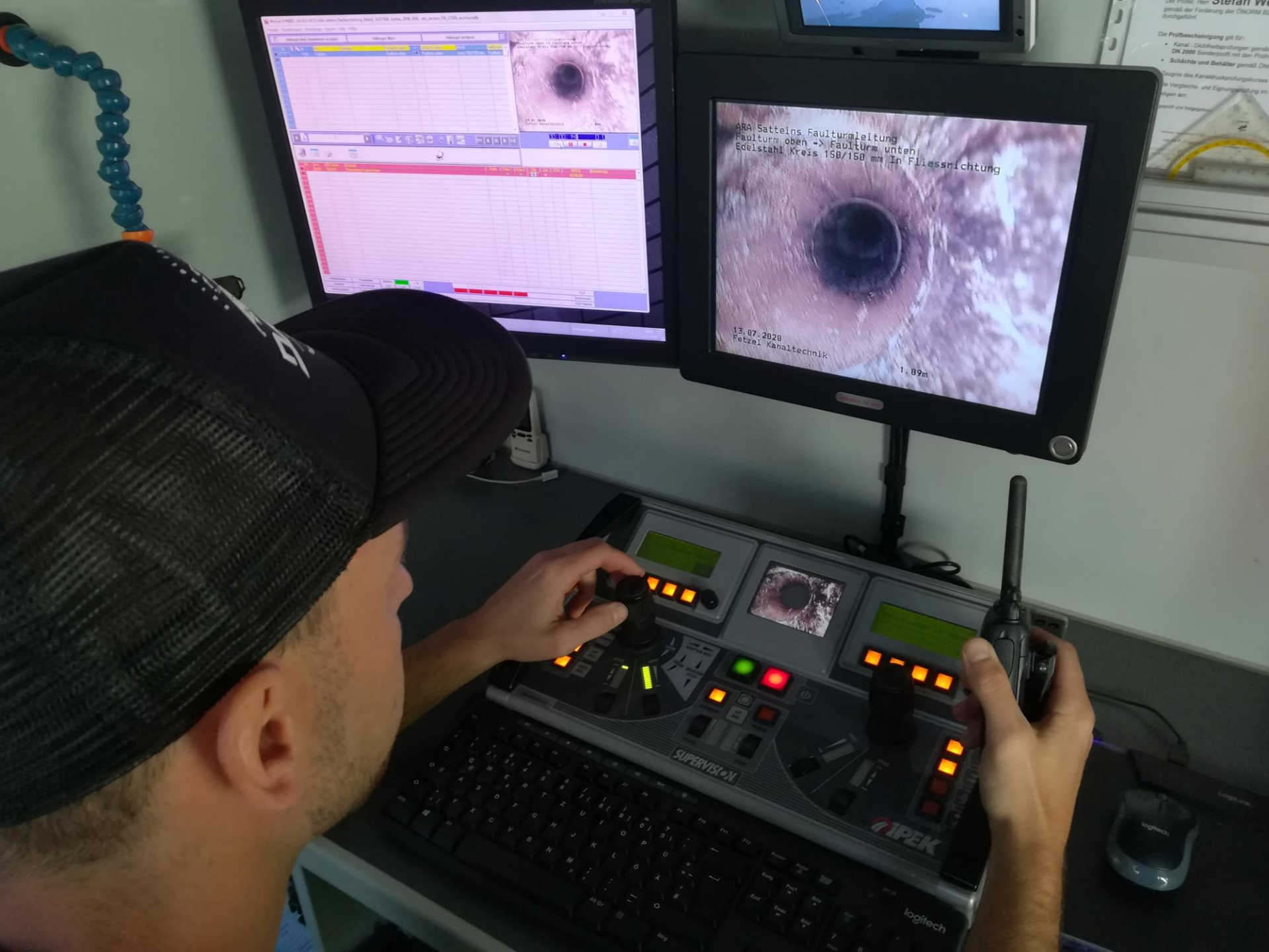
Kamerabefahrung der Faulturn - Ablaufleitung
