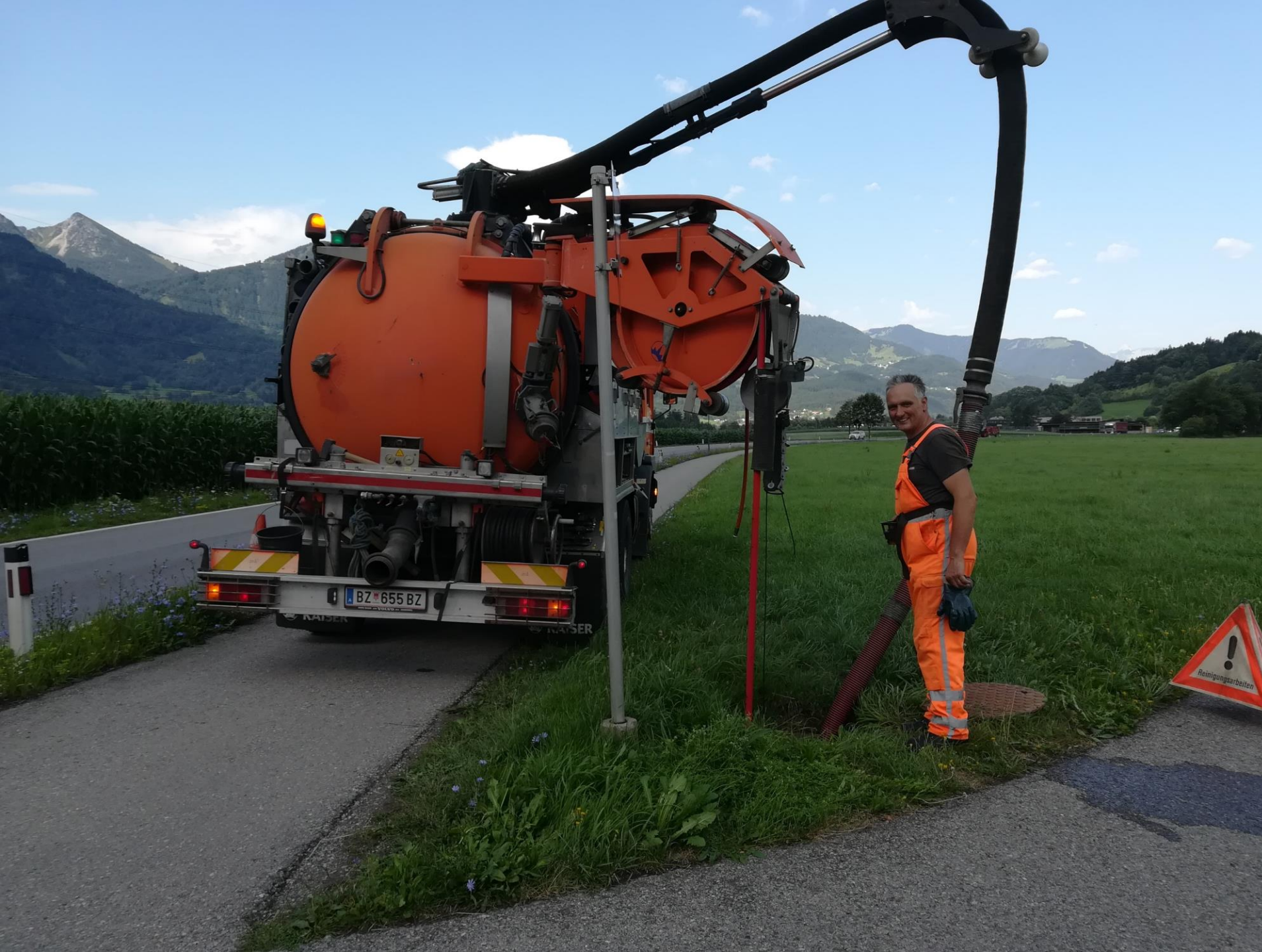
Franz Hartmann bei der Kanalreinigung im Zuge der Kanalsanierung von Schlins bis zum Regenbecken Thüringen
