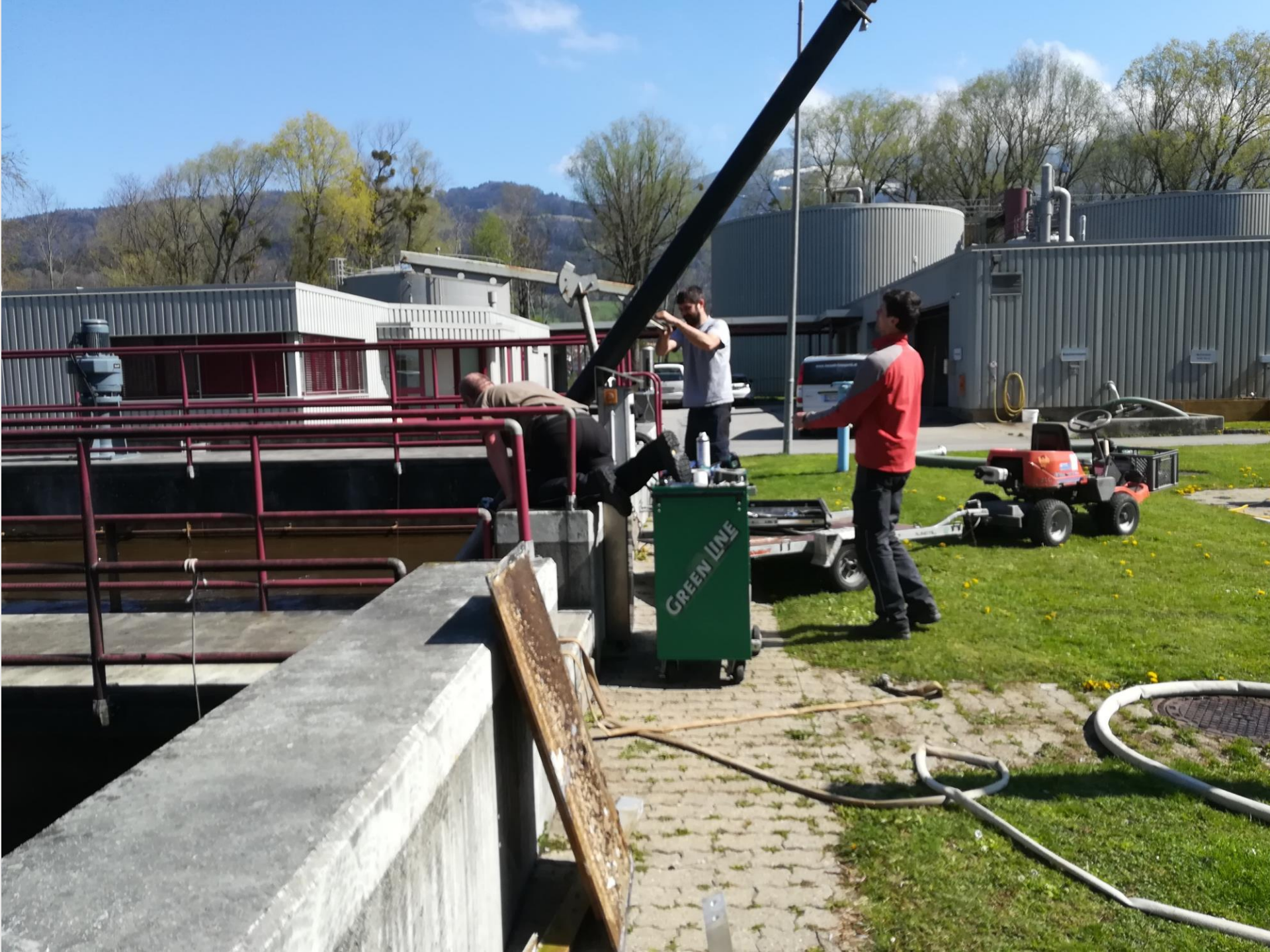
Ausbau des defekten Schiebers zwischen den Denitrifikations - Becken
