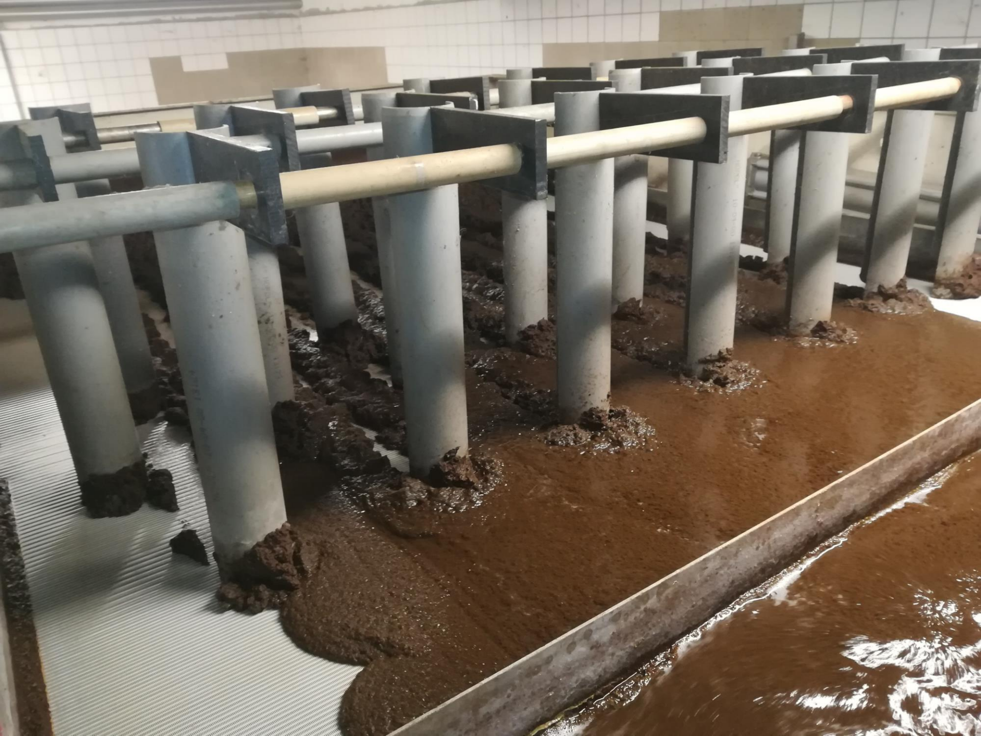
...montiertes neues Seihband
