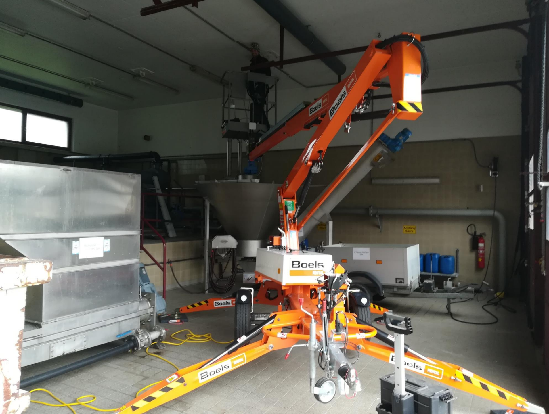
Umrüsten der Beleuchtung im Rechenhaus auf LED
