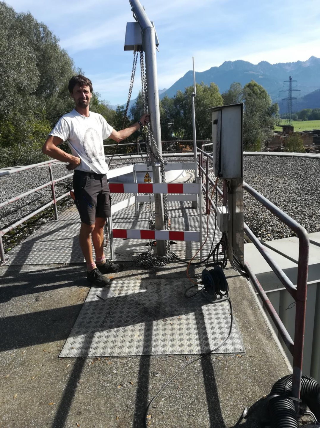
Wartungsarbeiten am Stapelbehälter - Rührwerk
