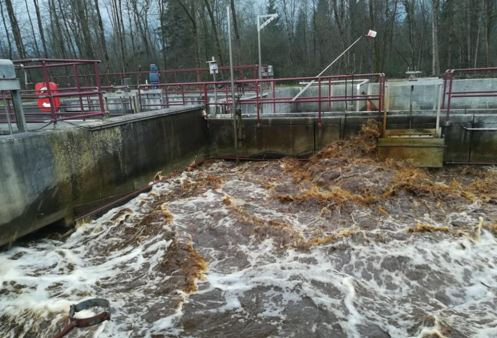
Schaden durch Bruch der Schmalwand im Belebungsbecken 2 während des Betriebes
