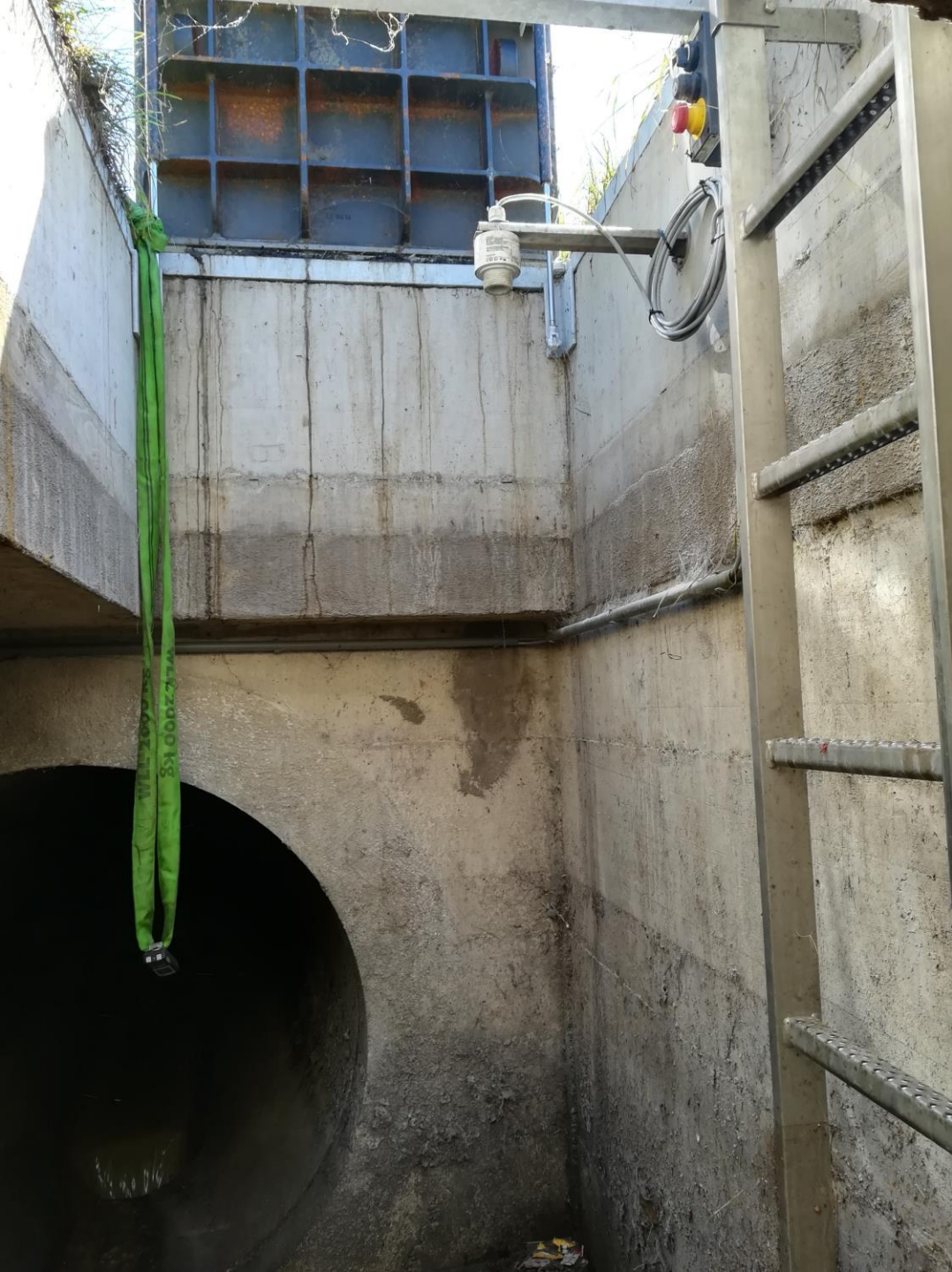
Kontrolle des Feststoff – Abscheiders im Regenrückhaltebecken in Thüringen
