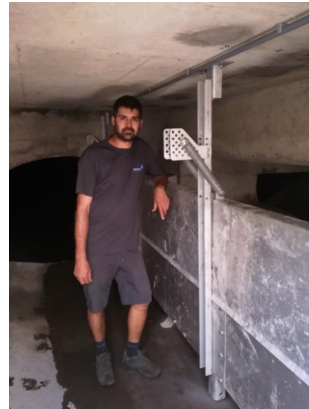
Einbau des Abwasser – Abschlagrechens in Thüringen
