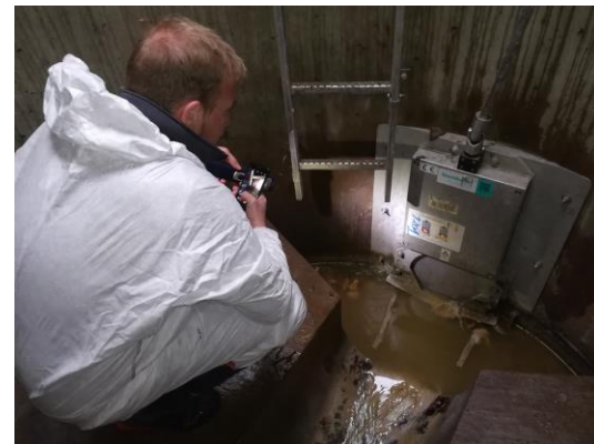
Einbau des Abwasser – Abschlagrechens in Thüringen
