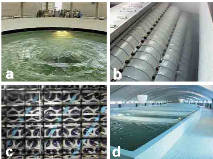
Bodensee- Wasserversorgung auf dem Sipplinger Berg
